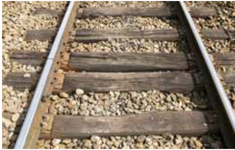
Rails courts sur traverses en bois
