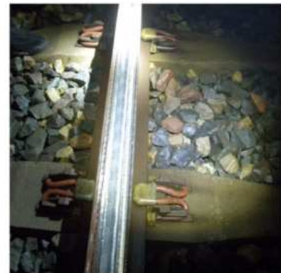
Rail après meulage
